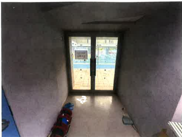
⑦プールサイド前入口 直進する(スタッフが扉を開放)
