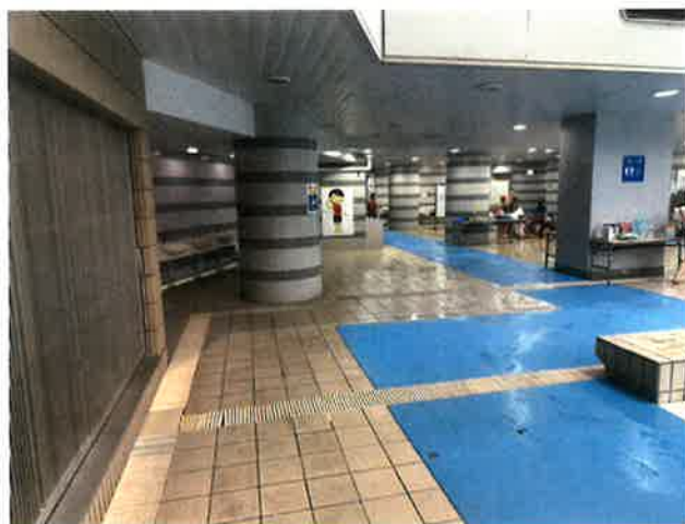
⑧プールサイド 直進する
